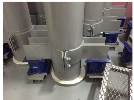
앵커 브라켓 시공 사진
