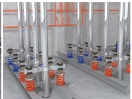
방진 스프링 설치 완료
