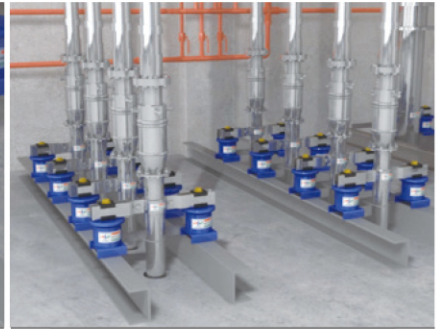
방진 앵커 설치 완료
