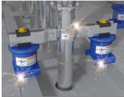
클램프 & 방진앵커 용접
