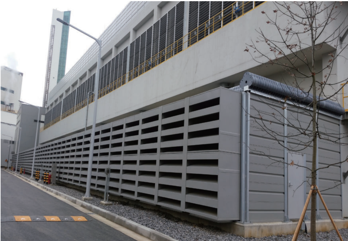
▲ 냉각탑 Wet Damper 소음루버 및 냉각탑 상부 방음벽 시공
