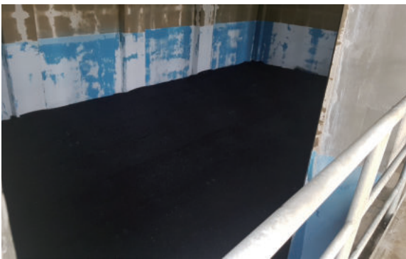
▲ 냉각탑 낙수 소음 저감 매트 설치
