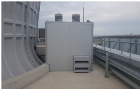
▲ 냉각탑 모터 소음 저감 Enclosure 설치
