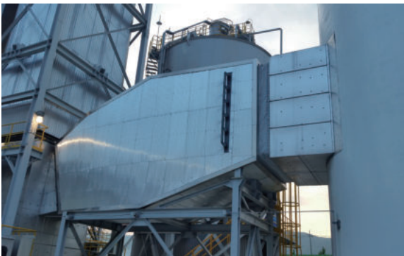
▲ ID Fan Duct Silencer
