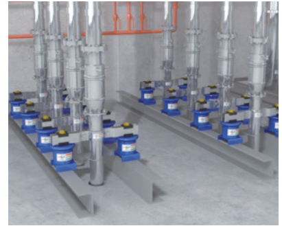
방진 앵커 설치 완료
