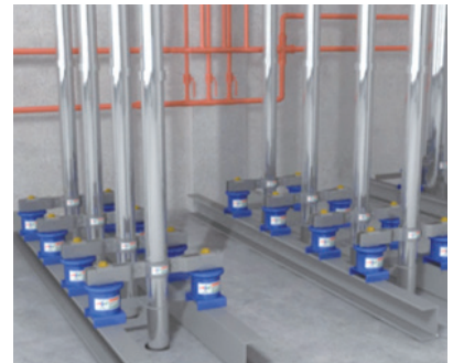
방진 가이드 설치 완료
