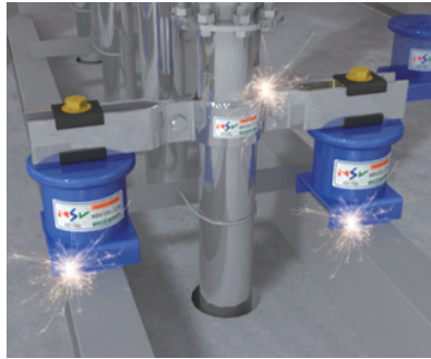
클램프 & 방진앵커 용접
