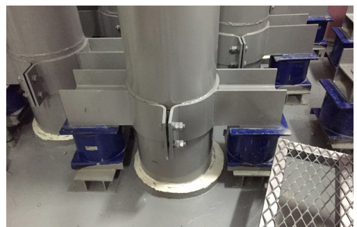
앵커 브라켓 시공 사진 (평촌)
