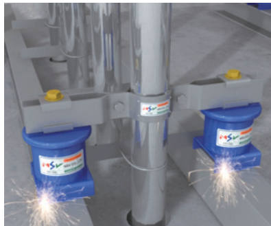
방진기 하부 용접
